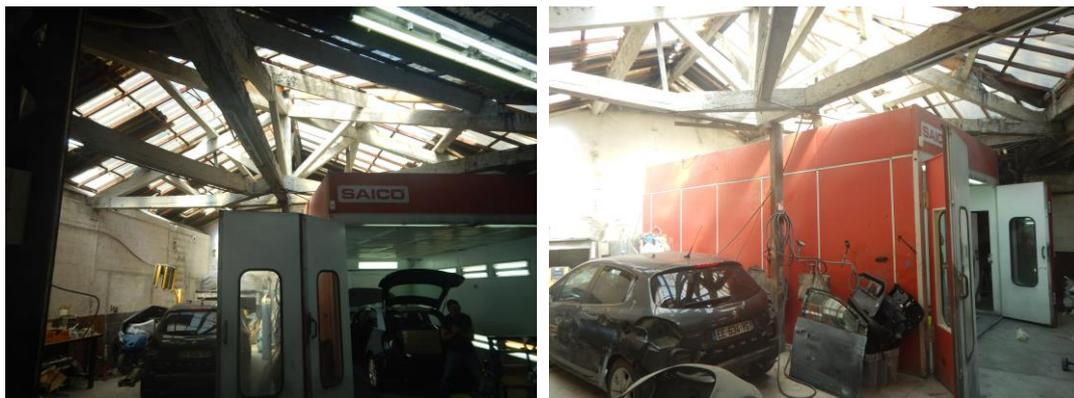
Elle est composée de panneaux ondulés translucides et de tôles ondulées en éverite.
